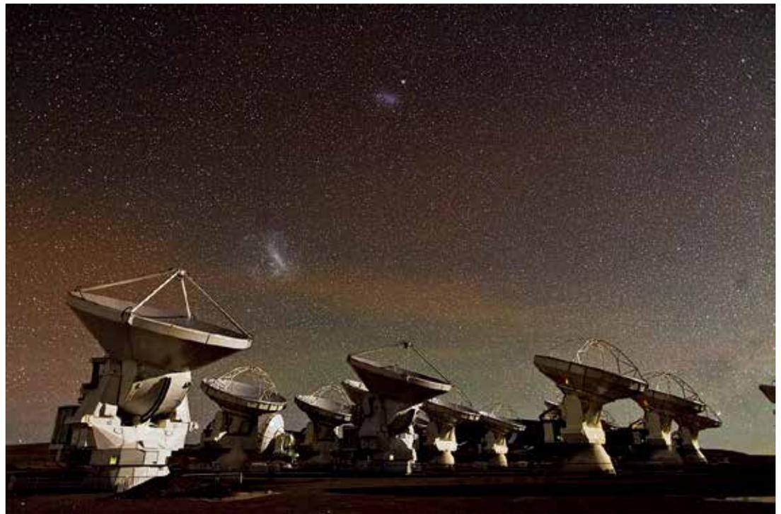
FIGURA 1. EL GRAN ARREGLO MILIMÉTRICO DE ATACAMA CONSTA DE 64 ANTENAS UBICADAS EN UNA PLANICIE A 5000 METROS SOBRE EL NIVEL DEL MAR. ESTE RADIO TELESCOPIO ESTÁ DISEÑADO PARA CAPTAR LA EMISIÓN DE LAS NUBES FRÍAS DE NUESTRA GALAXIA. FOTO: CORTESÍA.
