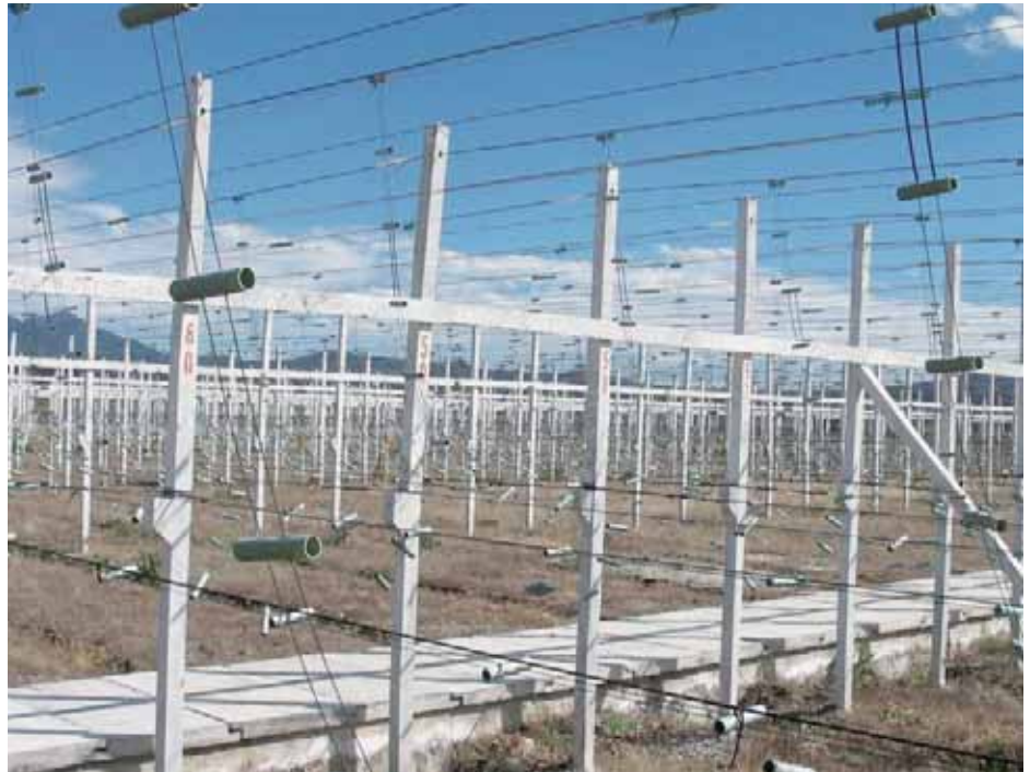
FIGURA 1. FOTOGRAFÍA DE LA ANTENA DEL OBSERVATORIO DE CENTELLEO INTERPLANETARIO DE COENEO. LA ANTENA CONSISTE EN UN ARREGLO DE 4096 DIPOLOS CUBRIENDO UN ÁREA DE 9,600 METROS CUADRADOS (140 M EN LA DIRECCIÓN ESTE-OESTE Y 70 M EN LA DIRECCIÓN NORTE-SUR). FUENTE FOTO: WWW.MEXART.UNAM.MX
